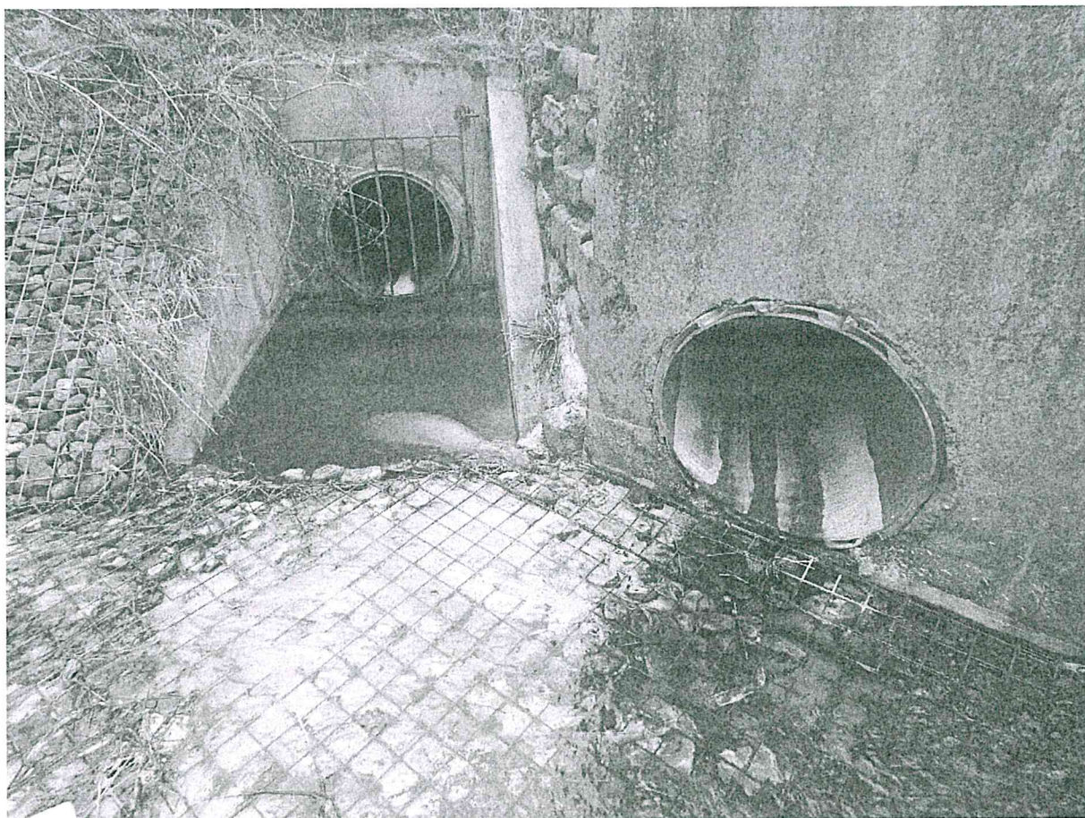
Zdjęcie nr 2 – Zanieczyszczone rury białą zawiesiną
